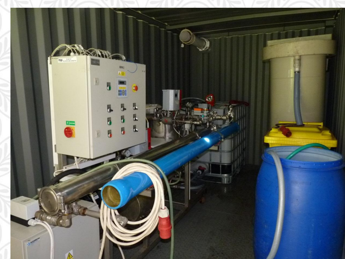
Obr. 2: Jednotka reverzní osmózy
